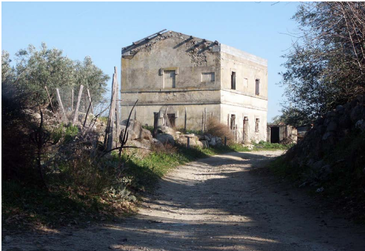
Casello ferroviario, Foresta di Petilia P.
